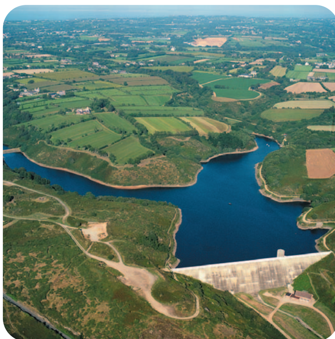
Val de la Mare Reservoir
